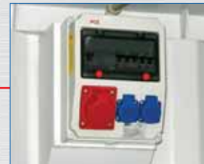
panou electric cu prize încorporate
